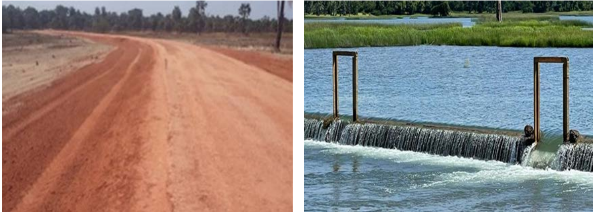
Photo 1-2 : digue de rétention de Diango (Ziguinchor) et Seuil deversant de Binago (Sédhiou)x
